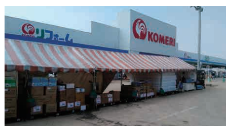
災害発生時には、店舗復旧作業と並行して仮設売場にて商品供給に努めています。
