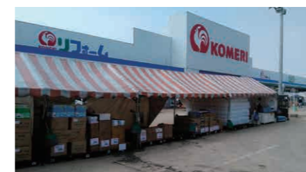
災害発生時には、店舗復旧作業と並行して仮設売場で商品供給に努めています。
